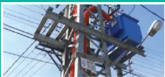
Công trình cáp nổi Overhead installation project
