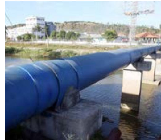
Dự án xây dựng hệ thống cấp nước sạch tại địa bàn tỉnh Nghệ An.
