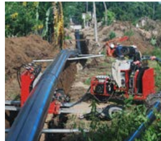
Dự án xây dựng hệ thống cấp nước sạch tại địa bàn tỉnh Đắk Lắk.
