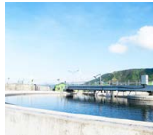
Dự án nhà máy xử lý nước thải Nha Trang, Khánh Hòa.
