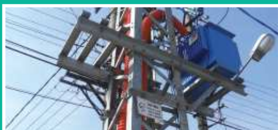
Công trình cáp nổi Overhead installation project
