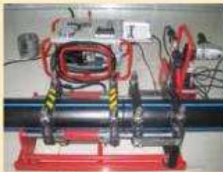
Hàn ống - Pipe Welding
